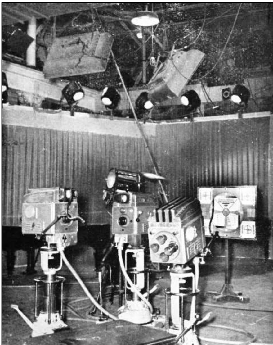
Obr. 22. Studio ČST se třemi superikonoskopovými (elektronkovými) kamerami vybavenými karusely se čtyřmi objektivy, polovina padesátých let.
