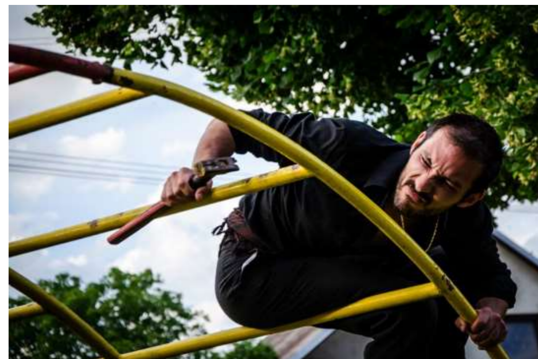
Obrázek 16: Dumrul (Raci Durak) při stavbě mostu na souši
