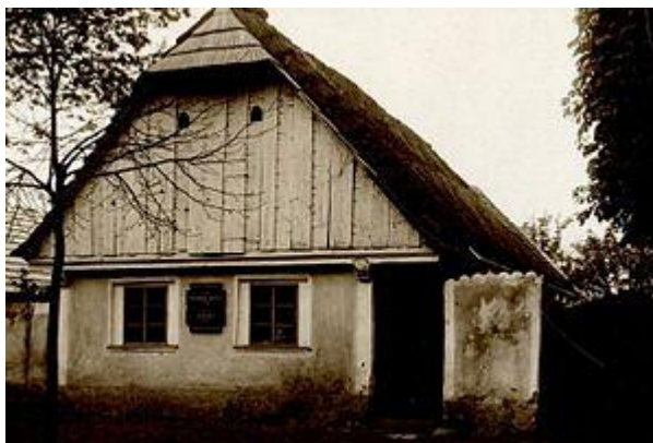
Obr. č. 1. Dům rodiny Bendových , zbořen v roce 1936 16
