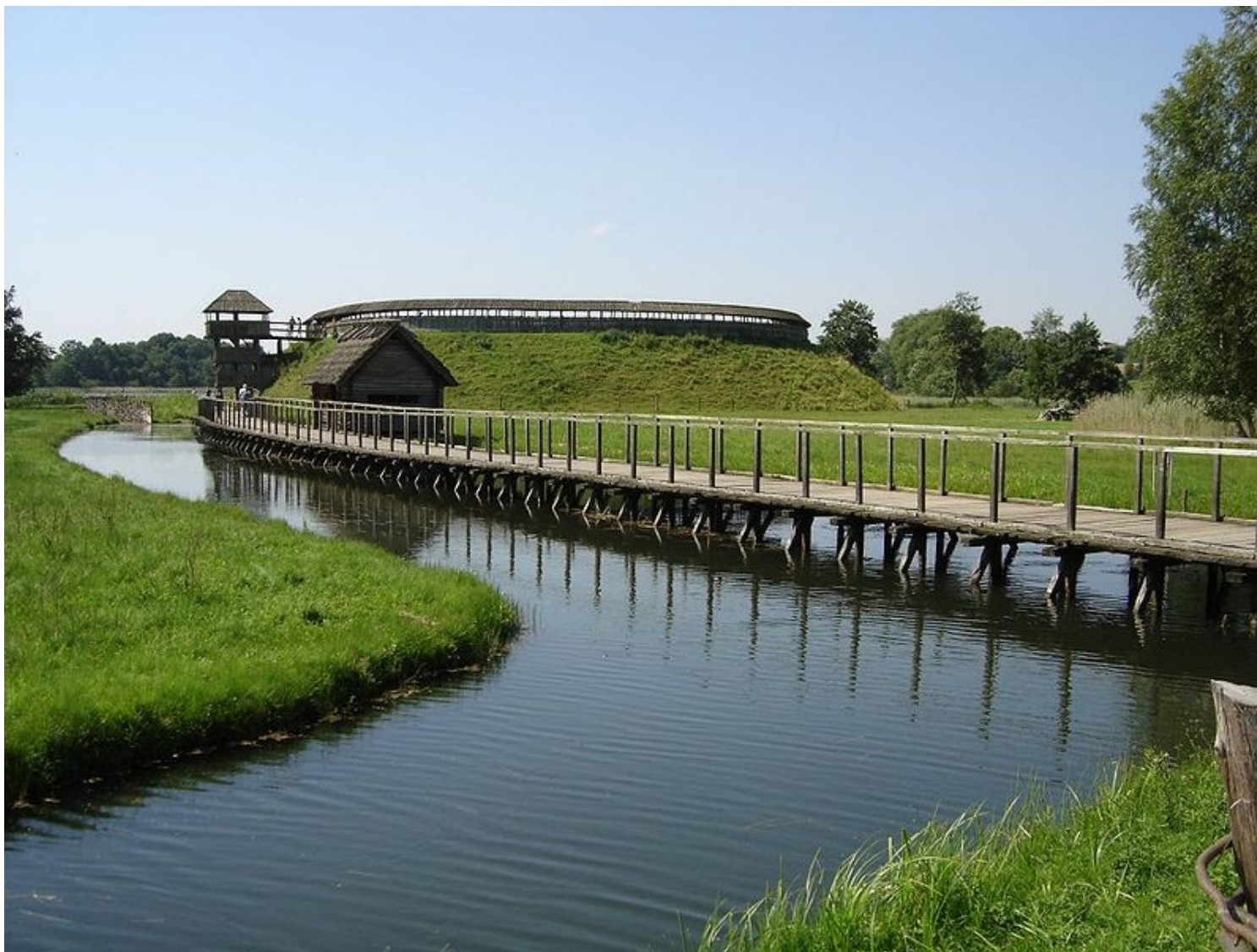
rekonstrukce slovanského hradiště se svatyní: Groß Raden bei Sternberg
